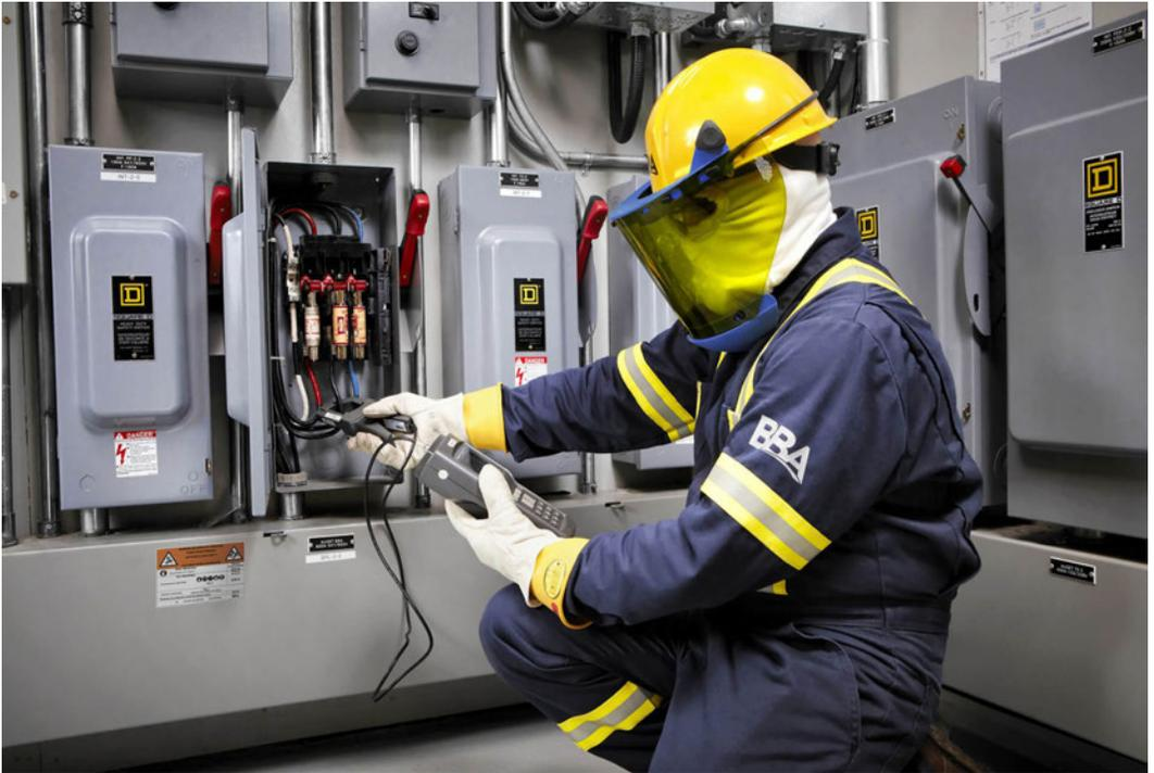
**Un arco eléctrico o Ara Flash es el resultado de una descarga eléctrica en los que los resultantes causan quemaduras graves en la piel.**
